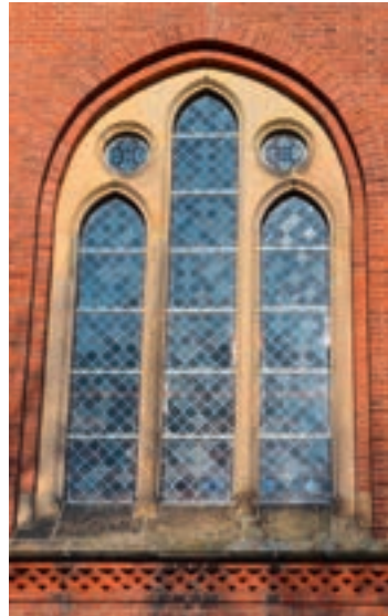
Dreiteiliges Fenster mit Rippen aus Sandstein
